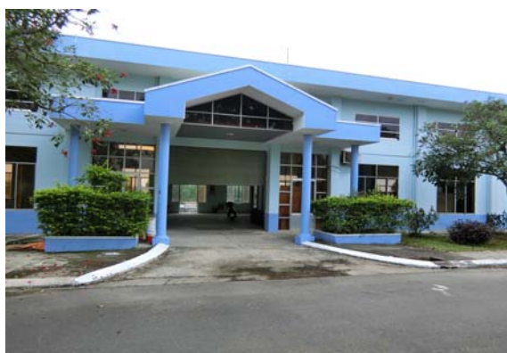
【Cau Do 浄水場 取水ポンプ場】
